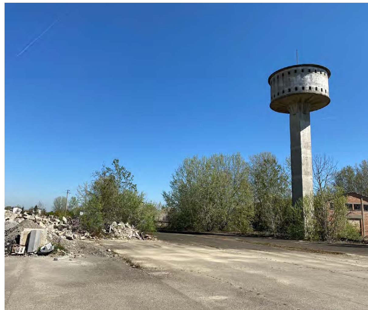
Figura 18: Torre dell'acqua Rilievo fotografico realizzato dagli autori
