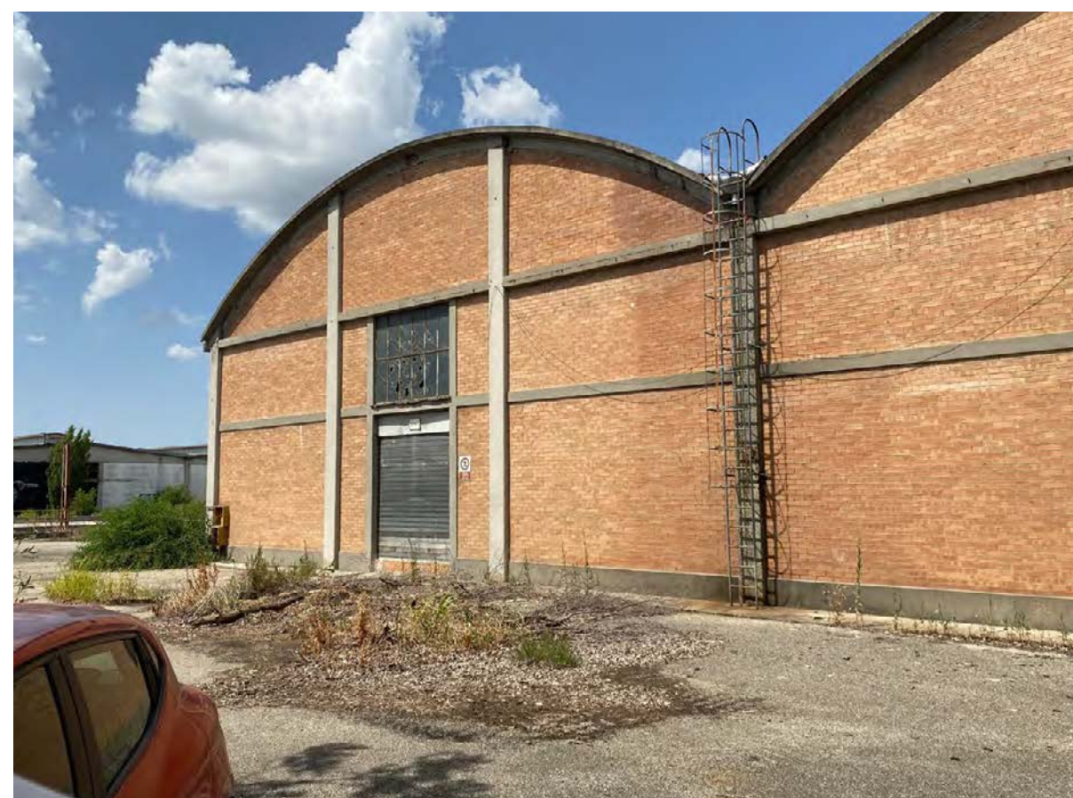
Figura 1 e 2: Capannoni O Rilievo fotografico realizzato dagli autori
