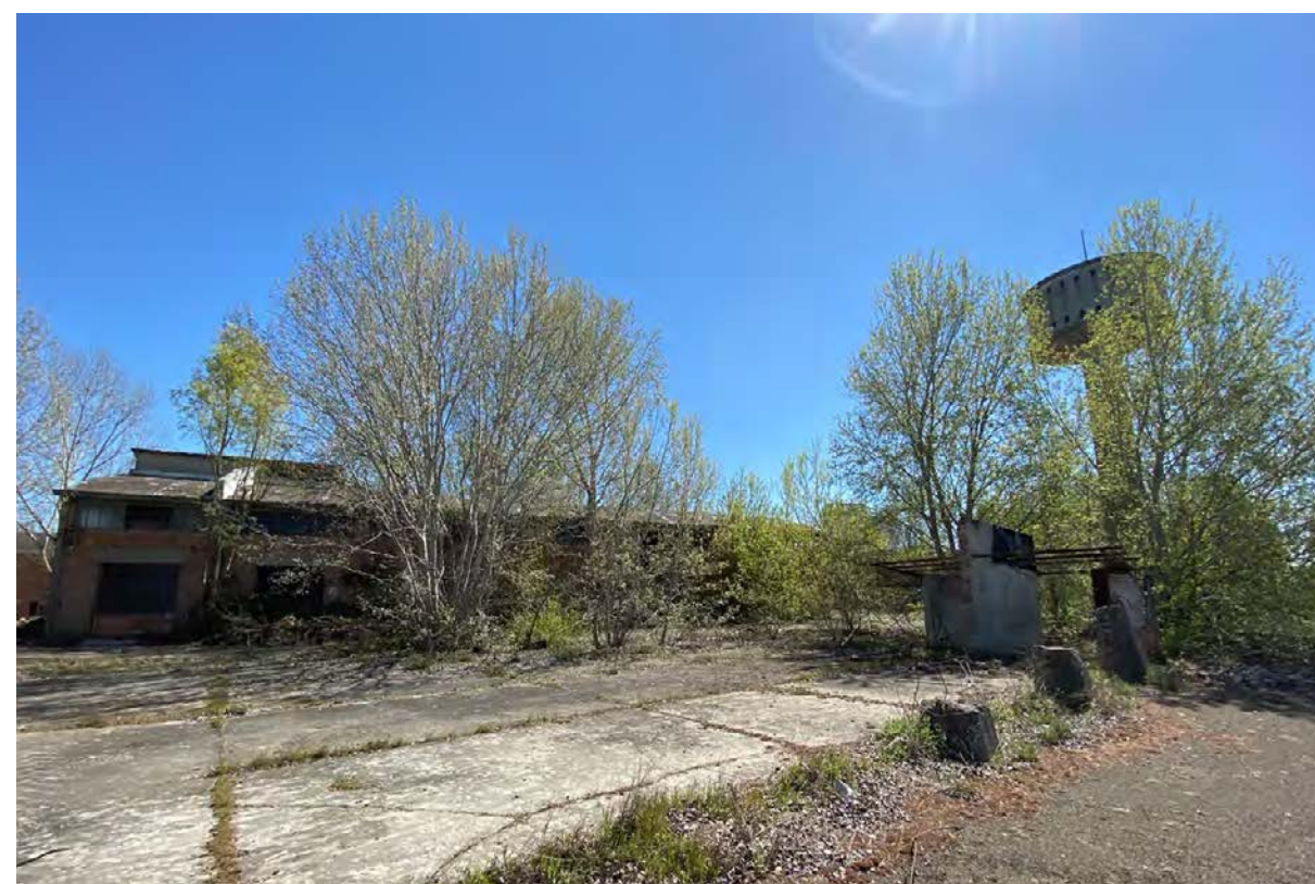
Figura 20: Viabilità Rilievo fotografico realizzato dagli autori
