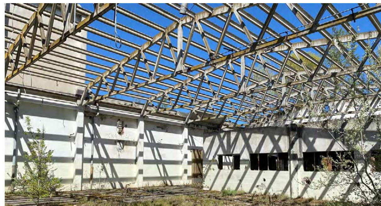
Figura 17: Edificio 25 Rilievo fotografico realizzato dagli autori
